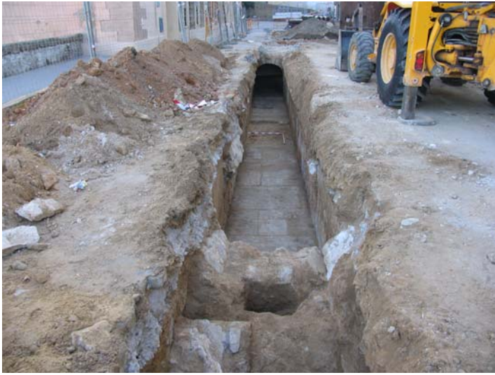
Vista general de las cloacas. C/ Santa Elena.
