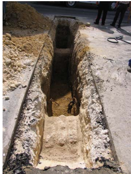
Zanja B. Muros 1 y 2. Atravesado Cuesta de las Calesas
