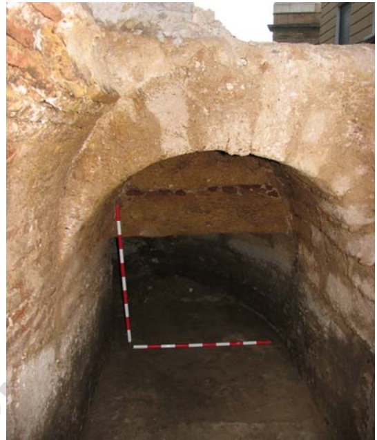
Vista bóveda desde el exterior. C/ Santa Elena.
