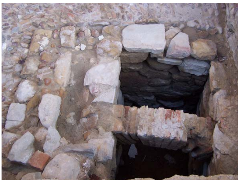
Lámina. I: Corte 1. CE 1. Adosamiento de muros.
