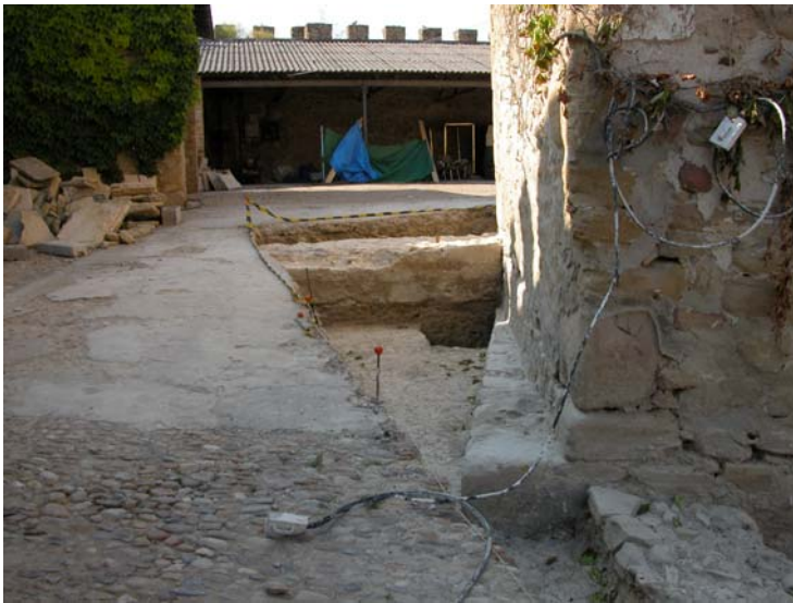
Lám. II: Corte 2. UE 4. Cimentación de la Torre de Sta. María.
