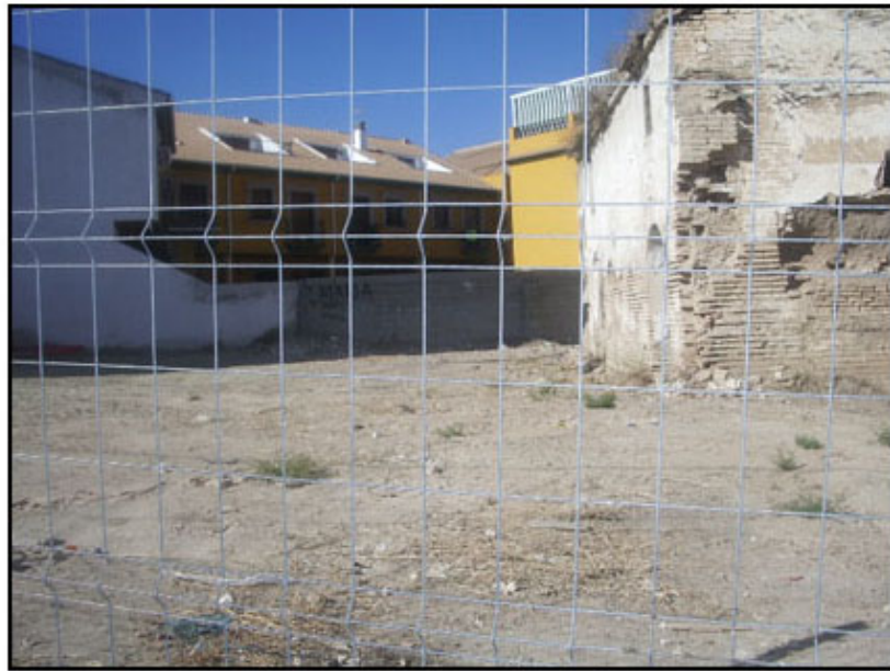
SOLAR ANTES DE LA INTERVENCIÓN
