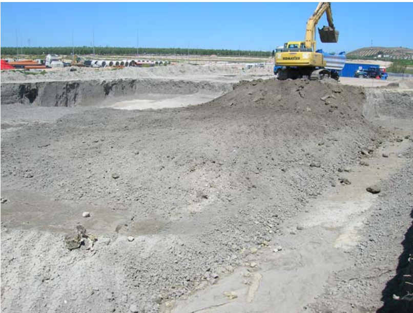
Lam 2. Planteamiento 2ª fase. Rebaje Corte 8.
