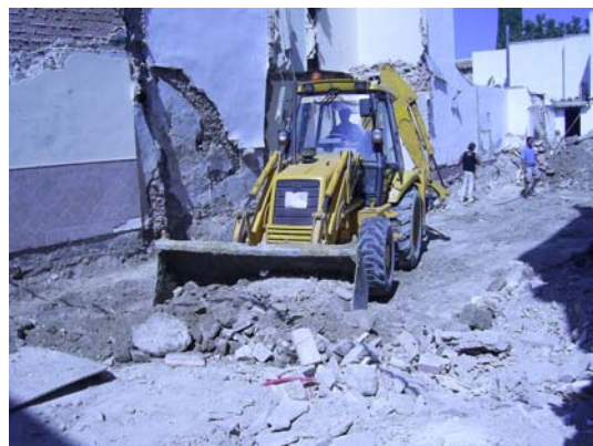
Lám. II: Retirada con cazo de limpieza
