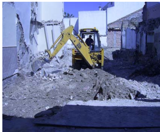
Lám. I: Trabajos de máquina giratoria
