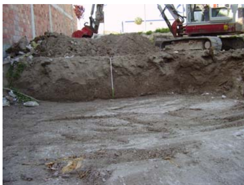
Lám. 2 Limpieza del solar, en el suelo en la esquina izquierda de la imagen se puede ver parte de una raíz.
