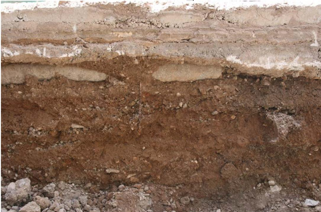
Foto 2: detalle de la estratigrafía estéril sobre la que se excavó el semisótano
