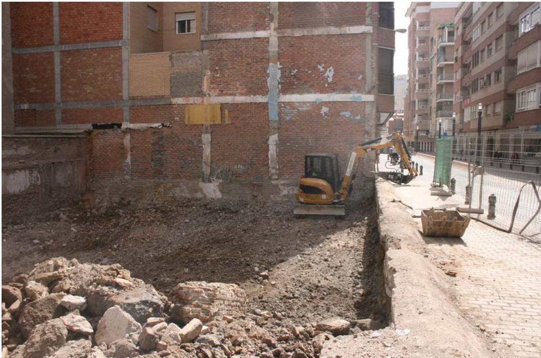
Foto 1: Proceso de demolición del muro del semisótano por la c/ Doctor Muñoz Fernández
