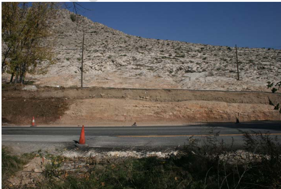
Foto 3; vista desde el oeste del Perfil-2 tras la intervención.
