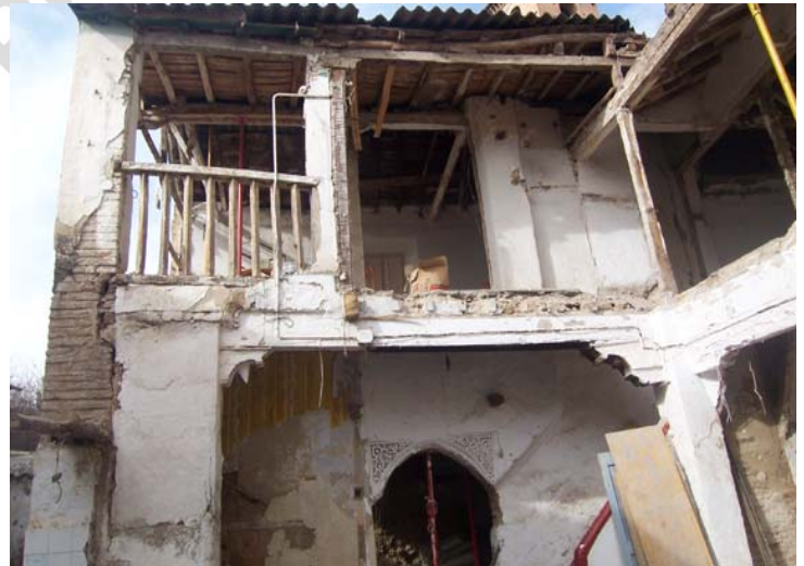
Lám.4. Ala Oeste del patio.
