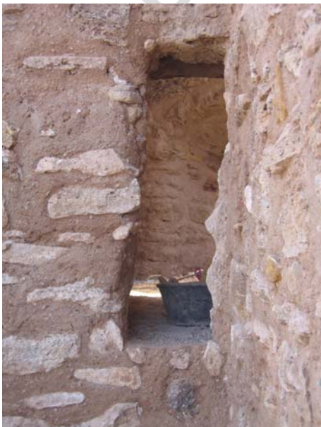
Detalle de la tronera E-32 tras su restauración.
