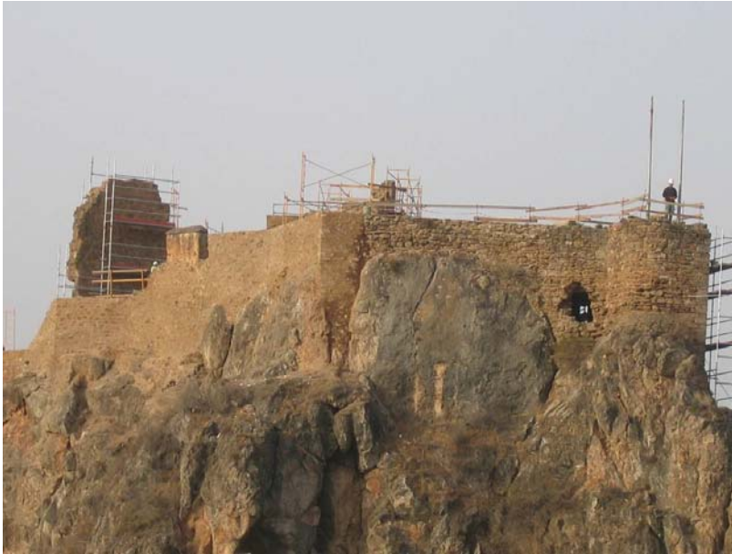
Panorámica del castillo durante los trabajos de restauración.
