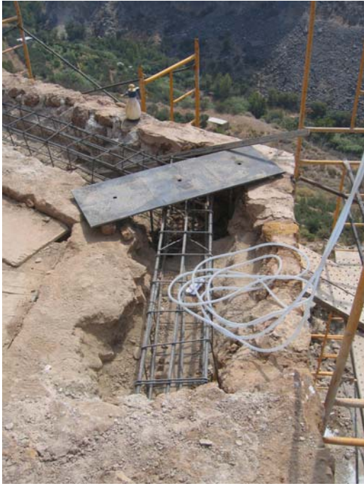
Detalle de una de las placas que sirven de cimentación para los pilares que sujetan la estructura de la torre del homenaje, situados en el E-9
