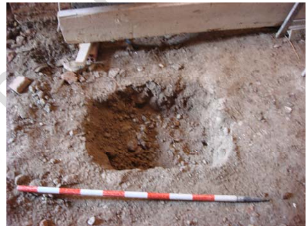
Perspectiva y detalle de la pequeña zapata para la nueva escalera de caracol.
