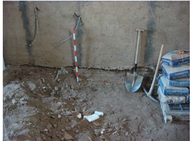
Excavación en la zona oeste hacia el exterior. A la derecha se ve la parte oculta del muro oeste. La profundidad indicada con el jalón es la aproximada que finalmente quedó en toda la superficie.
