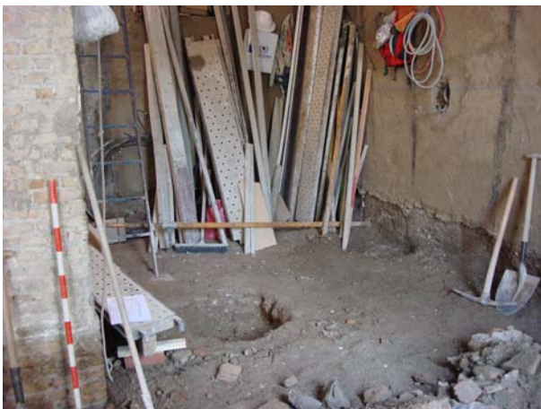
Perspectiva y detalle de la pequeña zapata para la nueva escalera de caracol.
