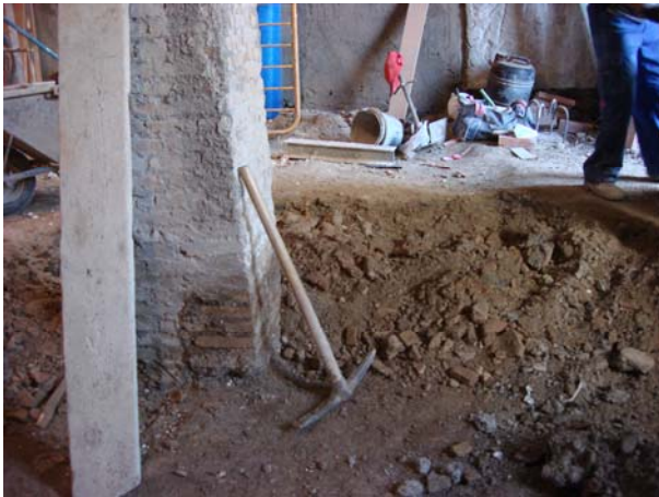
Excavación junto al pilar de ladrillo. A la derecha detalle de los materiales.
