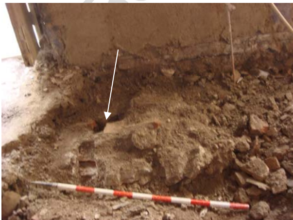
Excavación en dirección hacia la puerta. La flecha indica la aparición de la arqueta de ladrillo. A la derecha los materiales que formaban la arqueta (ladrillo macizo y perforado).
