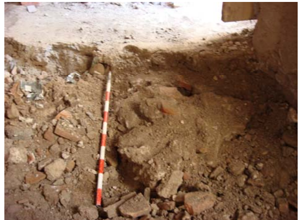
Excavación en dirección hacia la puerta. La flecha indica la aparición de la arqueta de ladrillo. A la derecha los materiales que formaban la arqueta (ladrillo macizo y perforado).
