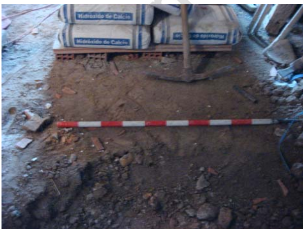
Excavación en la zona oeste hacia el exterior. A la derecha se ve la parte oculta del muro oeste. La profundidad indicada con el jalón es la aproximada que finalmente quedó en toda la superficie.
