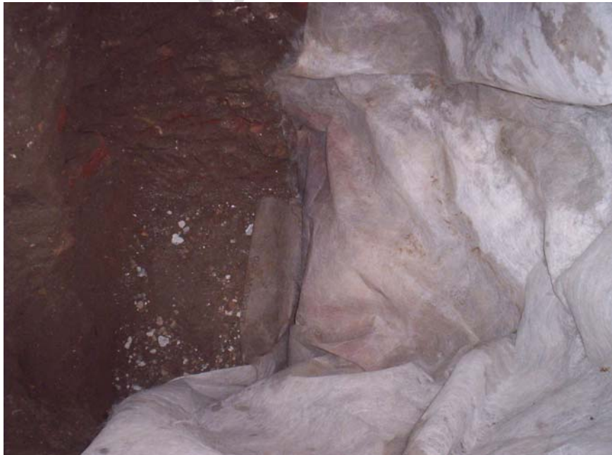
UEC-003 protegido con geotextil
