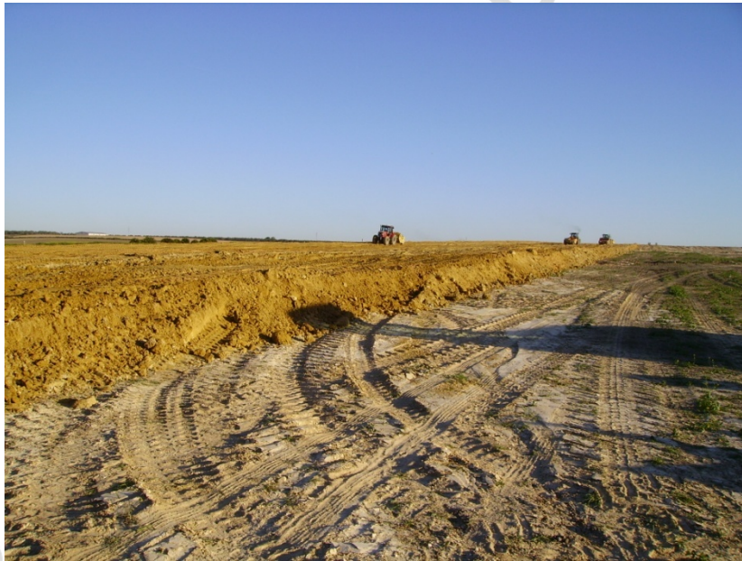
Lam 3: Final de la pista y zona de depósito del desmonte de estructuras constructivas
