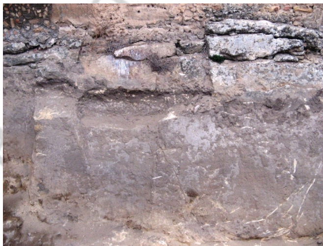
Figura 7- Detalle de las marcas registradas debajo de la zona de posible ubicación de la antigua puerta de acceso
