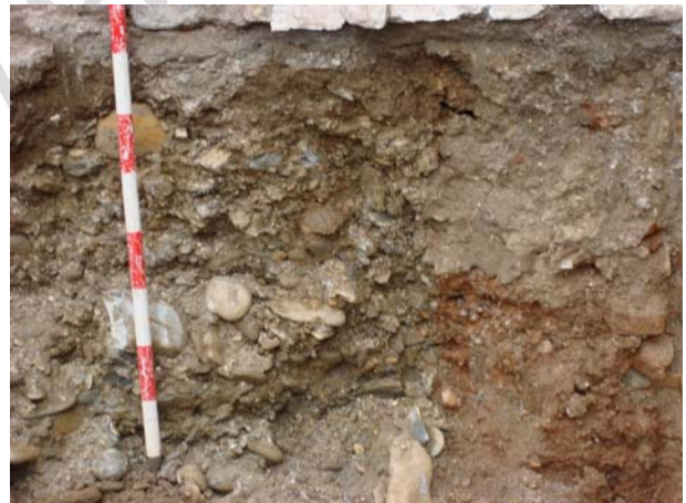
Detalle del frente este a cota acabada. Se ve el contacto de las gravas con el material arcilloso rojo. Abajo perspectiva y detalle del lateral sur a cota acabada.
