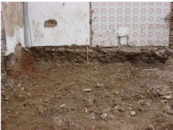
Detalle del frente este a cota acabada. Se ve el contacto de las gravas con el material arcilloso rojo. Abajo perspectiva y detalle del lateral sur a cota acabada.
