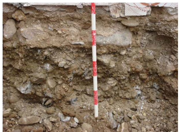
Detalle del frente este a cota acabada. Se ve el contacto de las gravas con el material arcilloso rojo. Abajo perspectiva y detalle del lateral sur a cota acabada.
