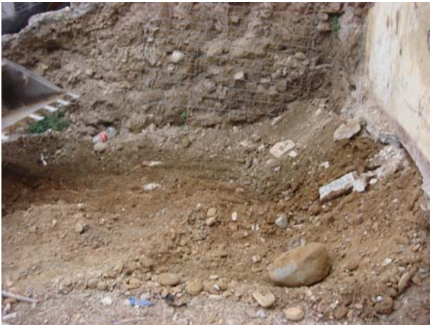
Perspectiva de la excavación en la esquina noreste. A la derecha relleno de grava y arena. Material más abundante en el solar.
