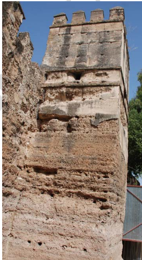
Figura 14. Torre 3. Cara Sur.
