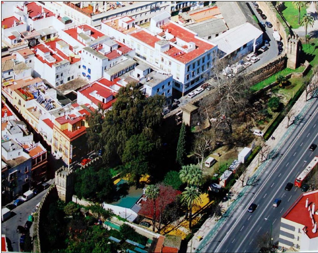
Figura 1. Vista aérea del sector antes de la intervención.
