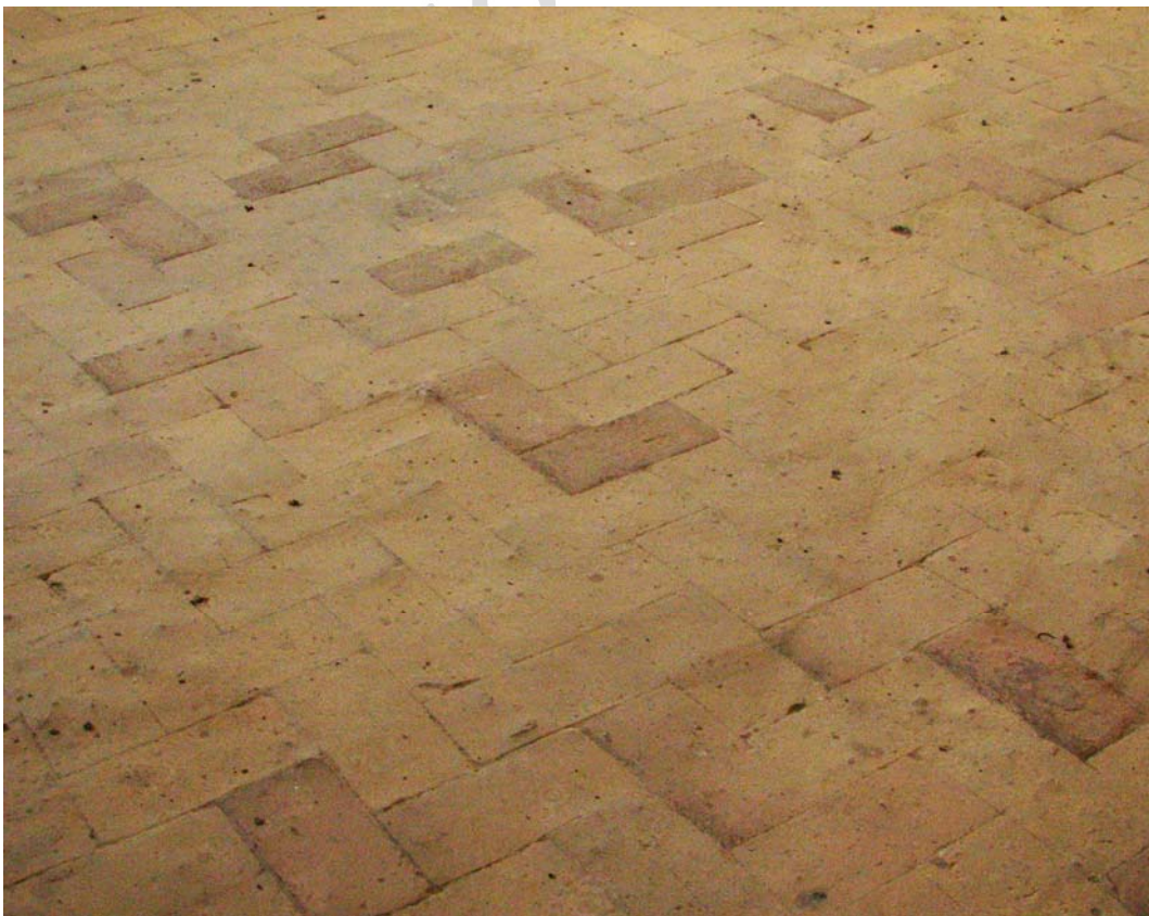
Fig. 15: Solería de ladrillo del coro.
