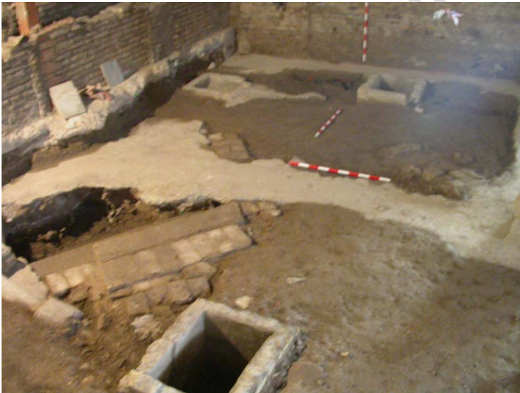
Figura 26. Zona de Acceso. Vista del sistema de arquetas y tuberías contemporáneas realizadas en la década de 1970.
