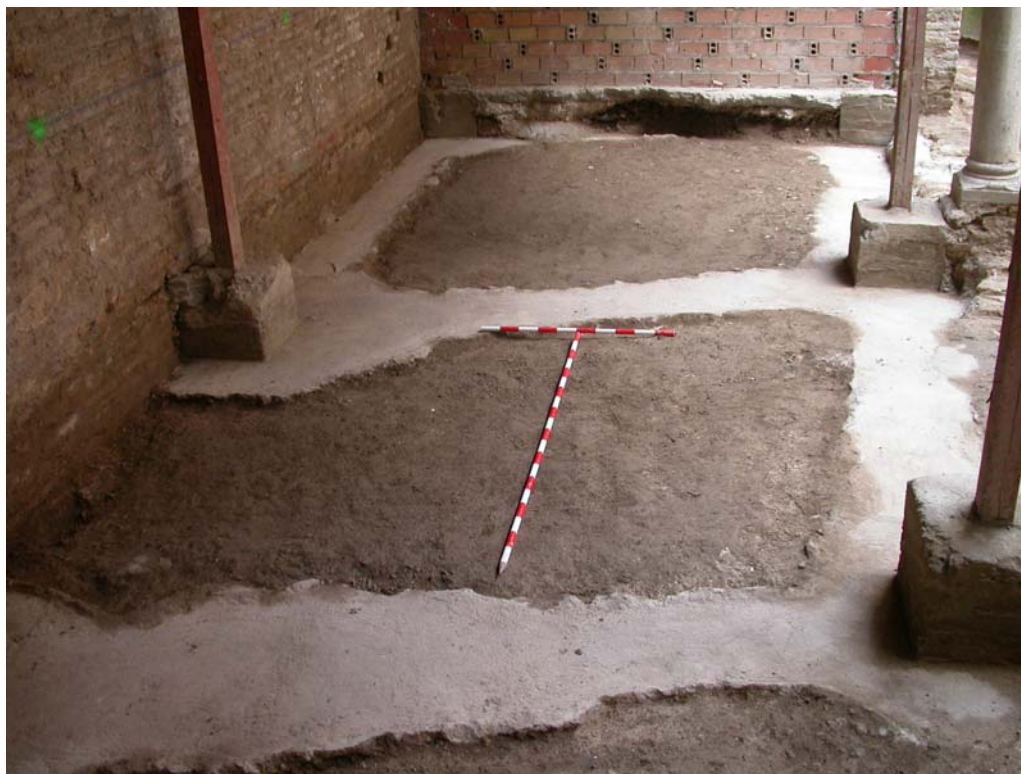
Figura. 25. Sector 3, vista del sistema de riostras y dados de hormigón que soportan la entreplanta o primera planta. Datado en los años 70 del siglo XX
