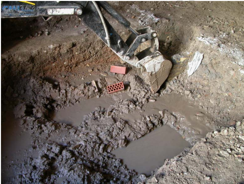
Figura 27. Vista del estado en el que se encontraba el hueco donde se proyecta el ascensor.
