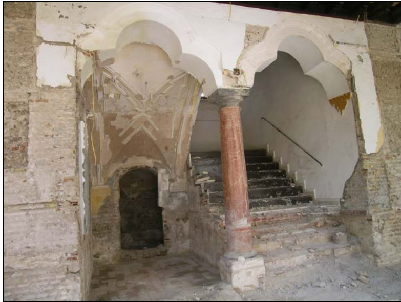
Lam. XIII. Acceso a la escalera
