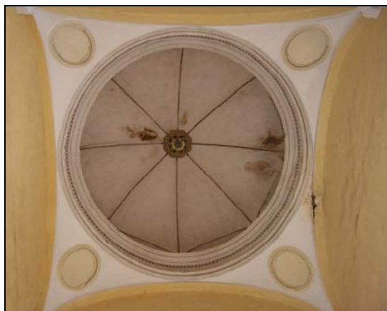
Lam. XIV. Bóveda que cubre la escalera
