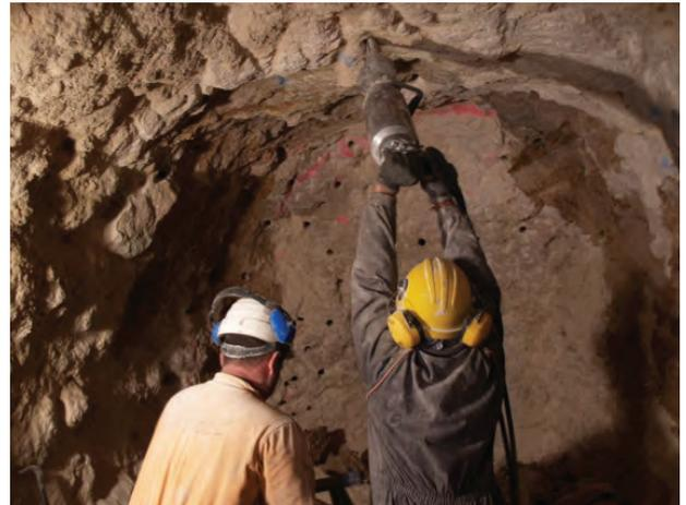
Lámina 3. Tratamiento con dinamita en el túnel.
