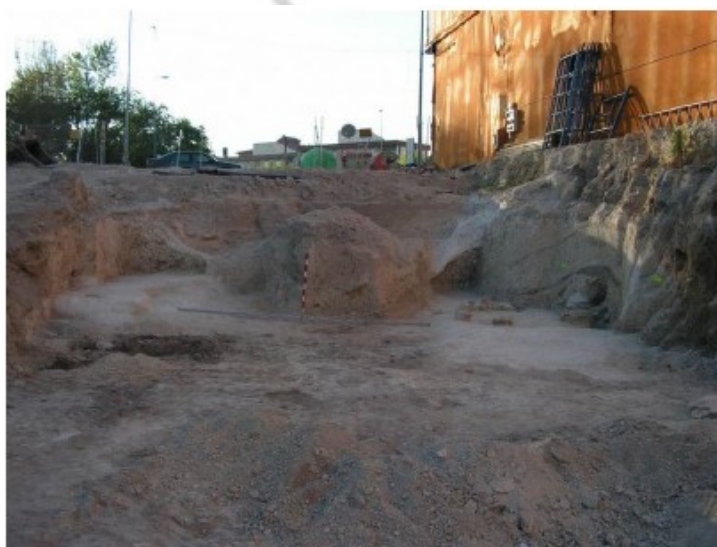
Foto 7: Vista de las tumbas 1 (dch) y 2 (iz) rotas por el Desagüe del Arroyo
