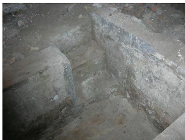
**A la derecha perspectiva de la excavación terminada en ese sector. En primer plano se ve una arqueta de registro, y en medio una conducción de cerámica.**
