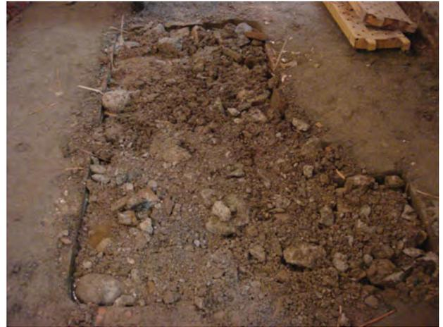
Detalle del registro y canalización de ladrillo. Perspectiva de la crujía con la excavación terminada. Se ve el zuncho del lateral.
