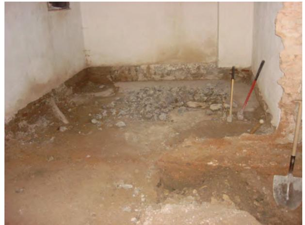
Retirada de la solería y solera de hormigón.
