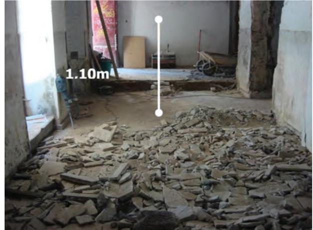
Nivel de relleno bajo la solería existente.
