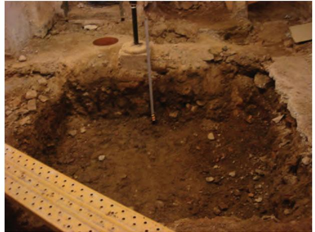
**Perfil de la excavación para el foso del ascensor.** Se ven ladrillos y atadores de cerámica.
