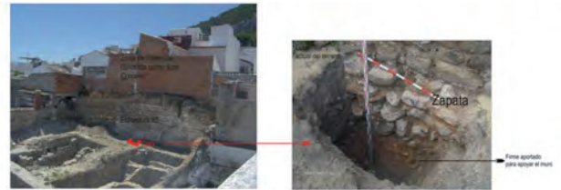
Lám. 4.- Detalle de la Estructura 85 y de la cata realizada
