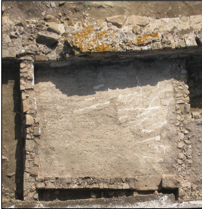
Figura 4. Vista cenital del sondeo 10 después de su excavación y consolidación.
