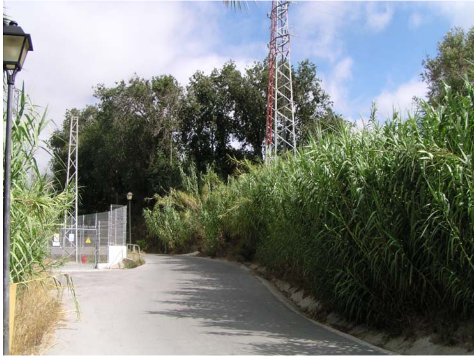
Fig. 1. Tramo 1. Subestación de Vejer de la Frontera.
