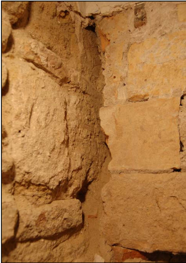
Figura 8. Detalle de adosamiento entre tabique y U.G. 1
