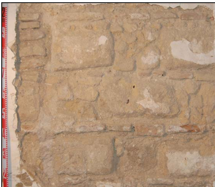
Figura 3. Aparejo mixto de sillares y ladrillo tosco. U.G. 1.
