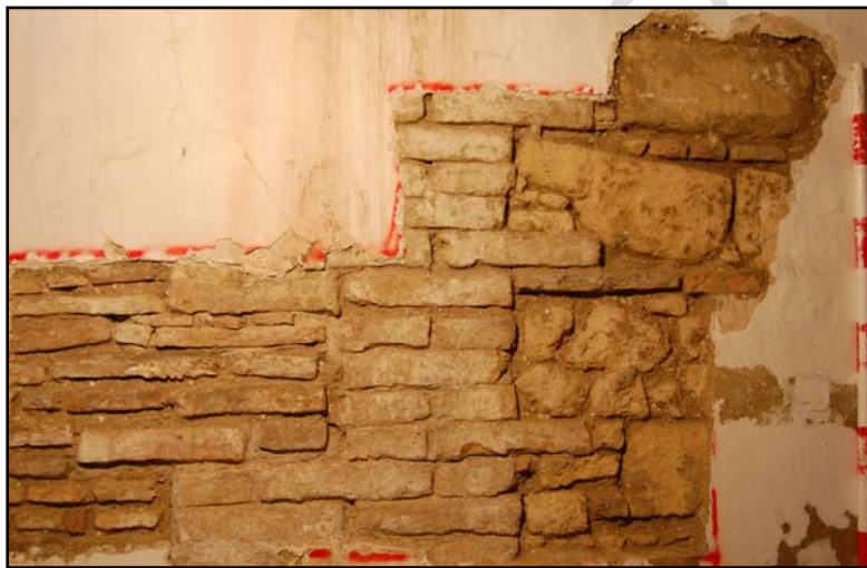
Figura 9. Detalle de encastre en U.G. 3 con U.G. 8. Quiebro del muro en planta baja.
