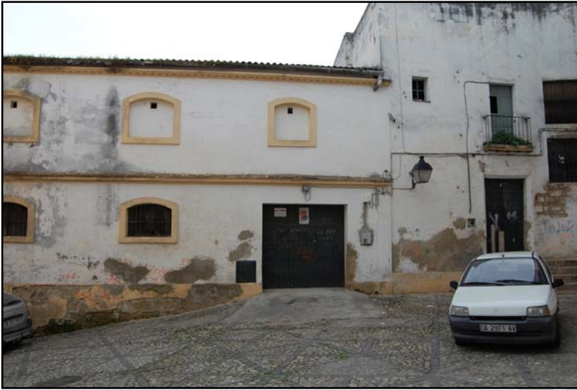
Figura 1. Vista general de la fachada.
