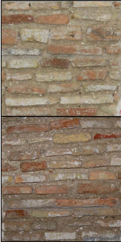
Figura 5. Aparejo de ladrillo tosco. U.G. 4 y 8.
