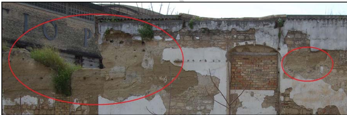
Detalle de restos de tapial y restauraciones en zona anexa a Granada 5-7.
