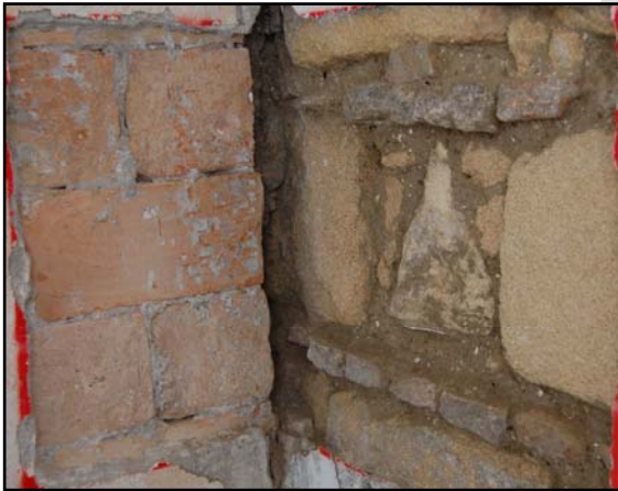
Figura 6. Aparejo tabiques ladrillo tosco.
