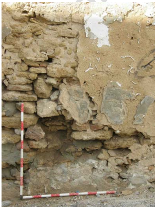
Lámina XI: La muralla presenta una fuerte pérdida de mortero, creando la pérdida de ripios, todo ello debido a la pérdida de su enlucido.
