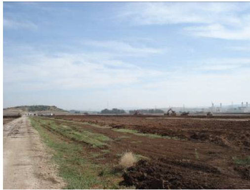
Lám. 1.- Desbroces iniciales de los terrenos. Orientación S-N.
