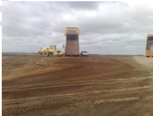
Lám. 10.- detalle de los trabajos mecánicos.
