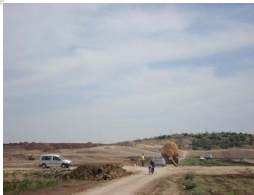
Lám. 4.- Detalle de las obras, Cerro de la Molineta y vertedero al fondo. S-N.
