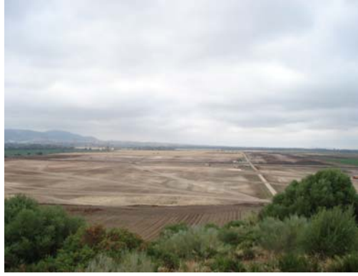
Lám. 5.- Detalle de las obras desde el Cerro de la Molineta N-S.
