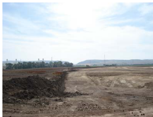
Lám. 2.- Detalle de terrenos parcialmente desbrozados. Orientación W-E.
