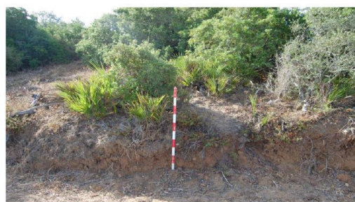
Foto 2. Sección Natural en el Terreno.
