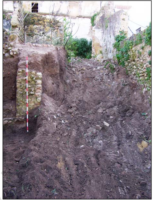
Lámina II: Rampa realizada para subir maquinaria para sondeos geológicos
