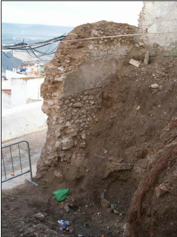
Lámina I: Rotura del solar al realizar sondeos geológicos
