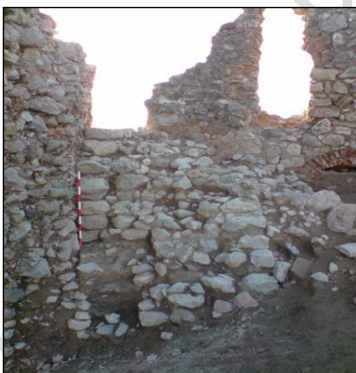
Lámina 5: Vista de la escalera o U.e.59 y de la ventana U.E.29.
