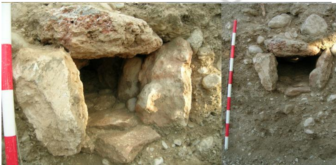
Ilustración 4: Canalización realizada con lajas de piedra.
