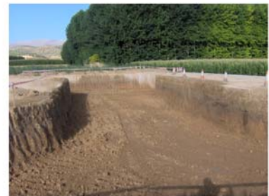
Obra de fábrica: perfil geológico en pk 0+400
