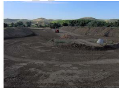
Tramo Norte: situación tras desbroce capa vegetal
