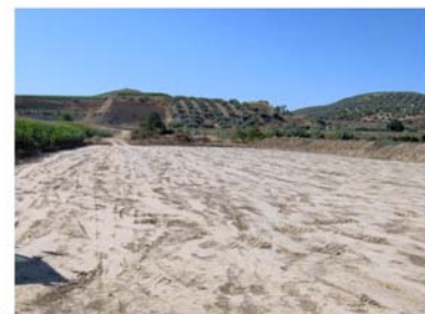
Tramo Norte: situación tras desbroce capa vegetal
