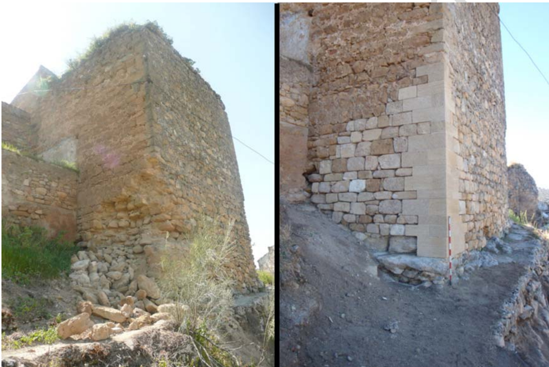
Fig. 2 Torre noreste del castillo de Zagra antes y después de la restauración
