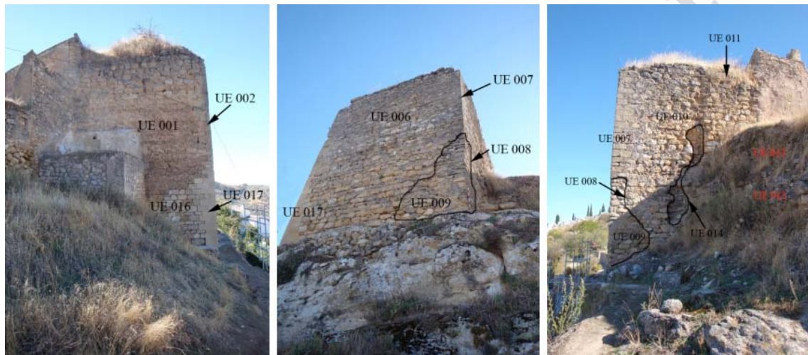
Fig. 4 Análisis estratigráfico murario en la torre noroeste del castillo de Zagra. De derecha a izquierda cara norte, oeste y sur.
