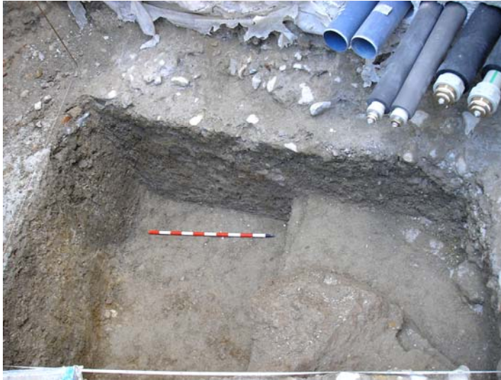
Lam. VII: Estado final de la excavación.
