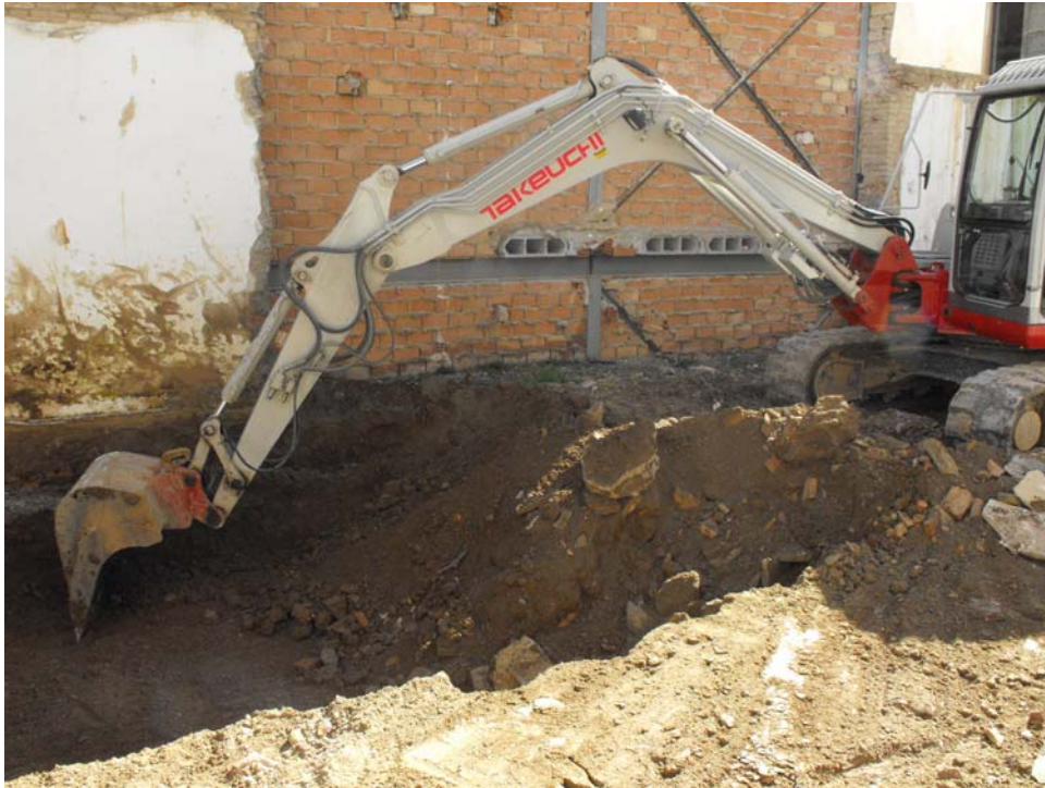
Lam. 3. Trabajos de desfonde donde se observan restos de material de derribo
