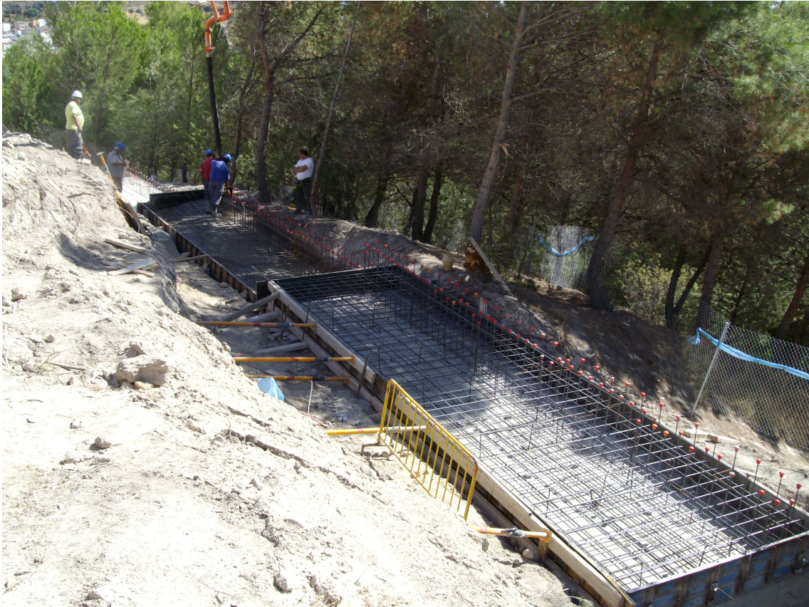
13. Encofrado tramo 1, secuencias de 10 metros.
