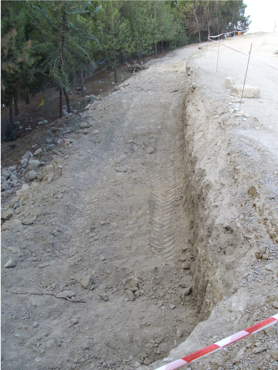
6. Destierro del camino, zona de nueva creación.
