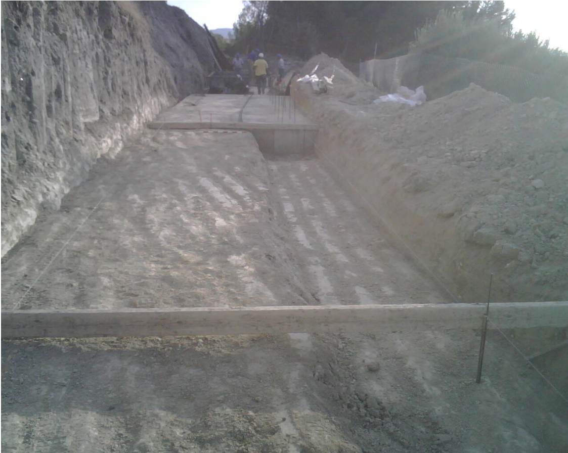
3. Sistema de destierro y encofrado.
