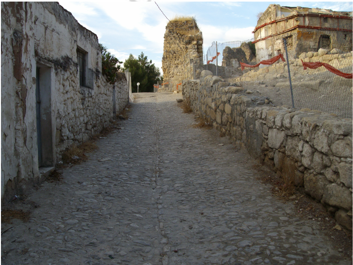
4. Calle San Bartolomé, tramo urbano.
