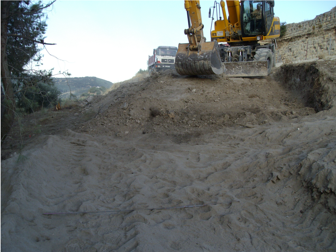
7. Destierro tramo central.
