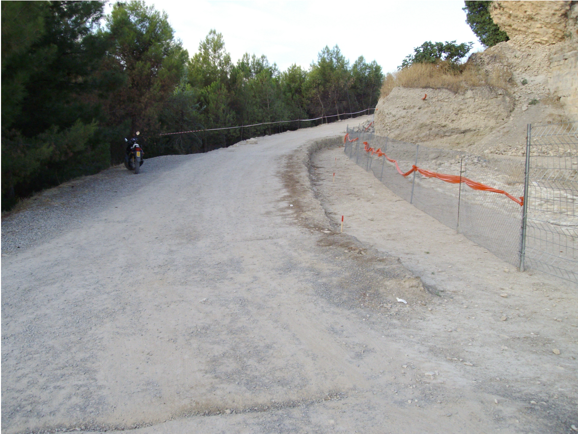
5. Tramo 1 del camino.
