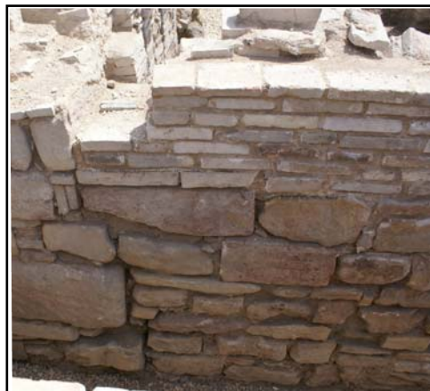
Lámina 4.- Detalle conservación bóveda
