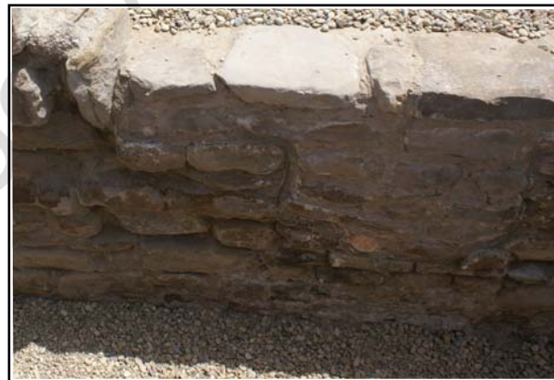
Lámina 3.- Fábrica y reconstrucción de muros
