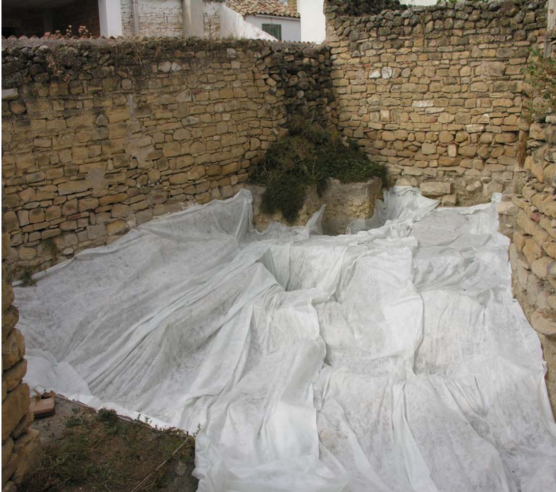
Fig. 11. Colocación del geotextil en la zona del sondeo n° 1. Fototeca ARQUIPO, sign. FD-2009-11-17-046. Año 2009.
