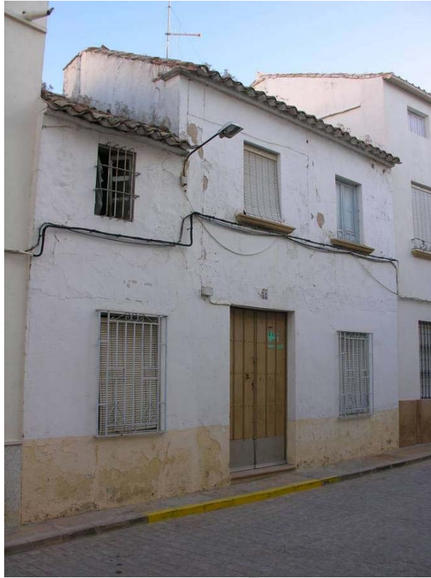
Fig. 1. Vista de la fachada de la casa nº 42 de la calle General Aguilera (antigua Gallos), antes de su demolición, donde se pueden reconocer las distintas obras de las dos viviendas preexistentes, objeto tanto del proyecto de nueva construcción como del arqueológico.
