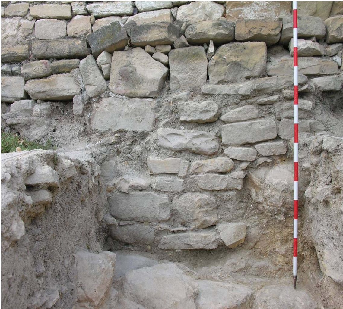
Fig. 8. Cimentación de mampostería (E-78), bajo la E-40, el muro medianero norte del solar que está escalonado. Esta cimentación corresponde al trazado de la muralla de la Villa.
