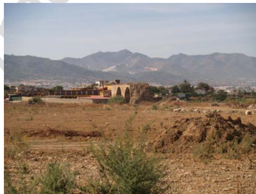
Fig. 2 – Acueducto de Fuente del Rey emergente
