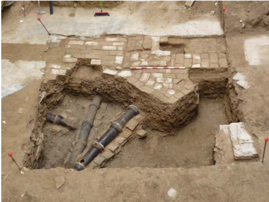
Lam 1: Las tres tuberías y su relación con los hallazgos previos
