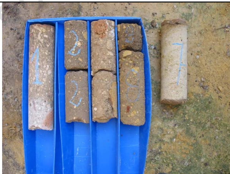
Lám. 4. Testigos para el análisis del material constituyente de los muros portantes.
