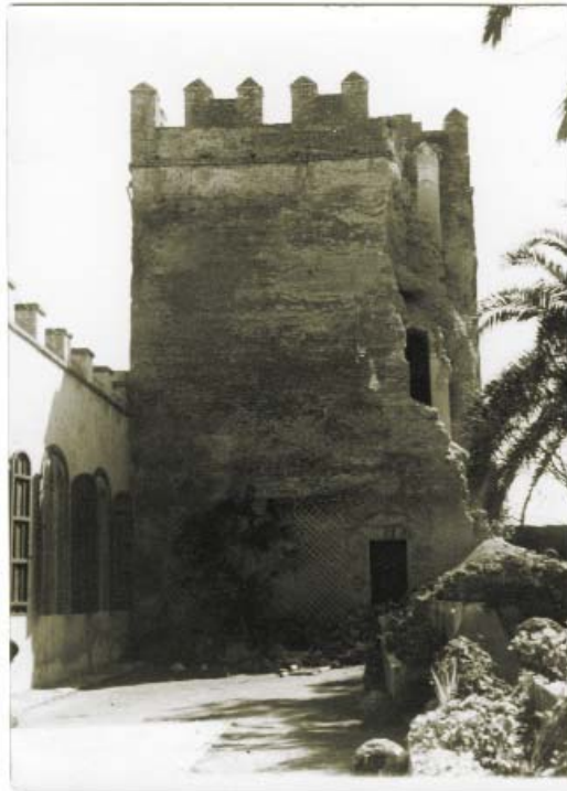
Lám. 11. Derrumbe accidental de la esquina reconstruida por Bonsor. Torre Campanita. 1963. AAVV: 365.
