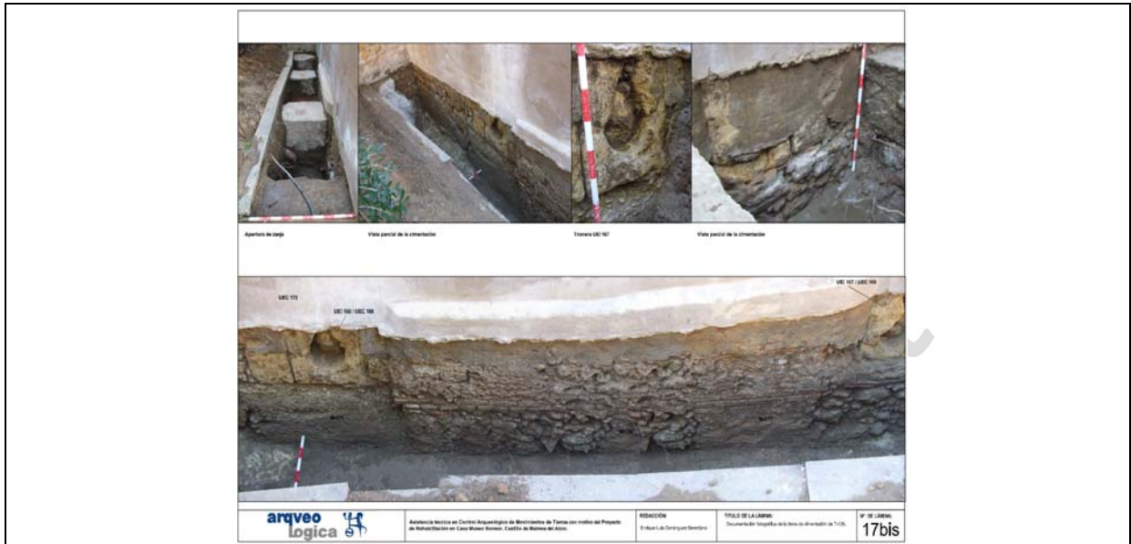
Lám. 8. Detalle troneras localizadas en la torre Derruida. Documentación fotográfica de cimentación de T-128.
