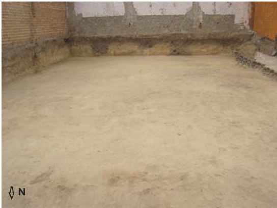
1. Estado del solar antes de la I.A.P
