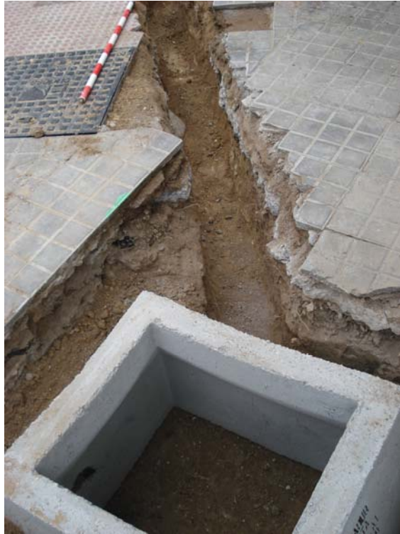
Lám. 5. Detalle arqueta en Avenida de Andalucía conexión con calle Félix Rodríguez.
