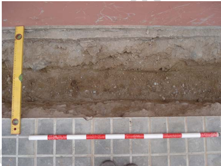
Lám. 4. Detalle zanja en calle Félix Rodríguez de la Fuente (N-S)
