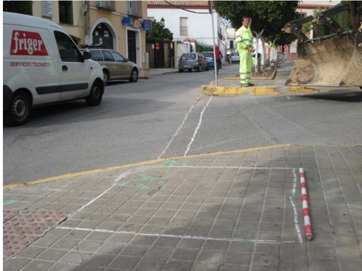
Lám. 1. Metodología: Replanteo de Zanjas y arquetas.
