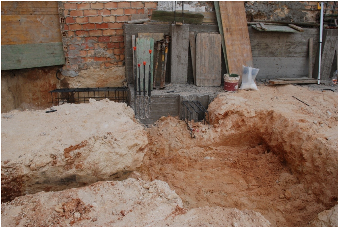
Foto 3.- Primer plano zanja para cimentaciones sector suroeste
