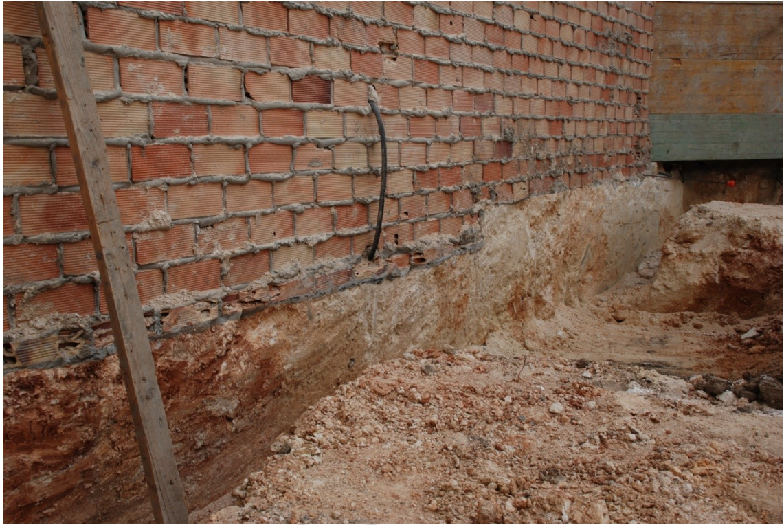
Foto 4.- Detalle del sector sureste
