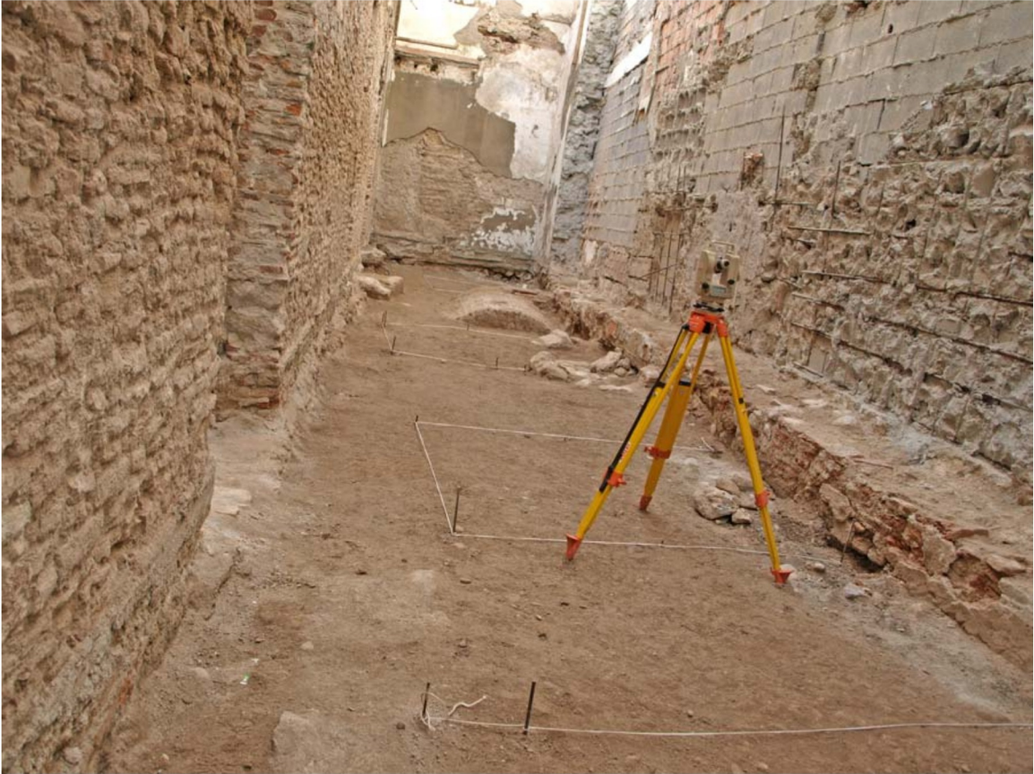
LAMINA 1.- Desde el Norte. Rebaje para "Losa de Cimentación" y Replanteo de Sondeos Arqueológicos.
