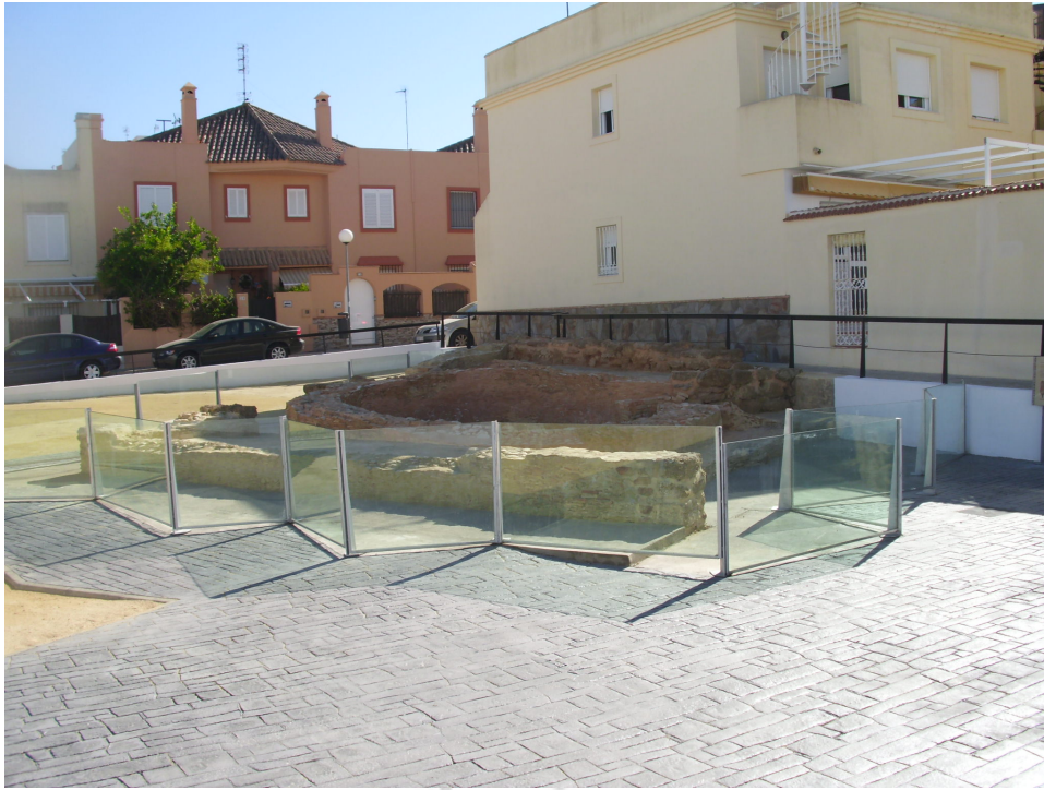
Figura 7. Estado del horno y área circundante tras la obra de limpieza y reacondicionamiento.
