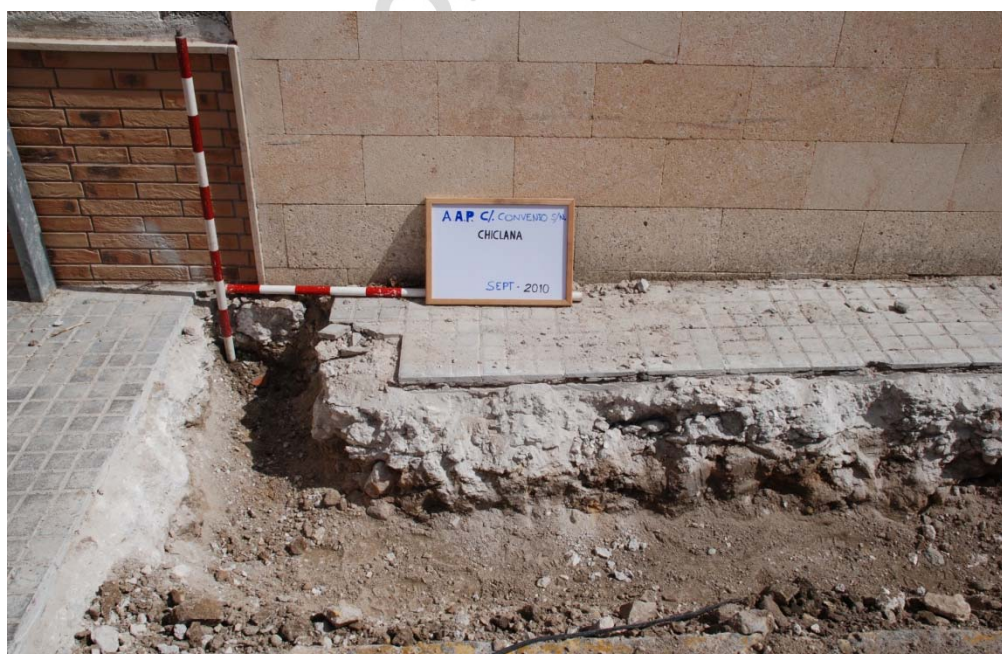
Foto 2.- Comienzo del rebaje de la zanja
