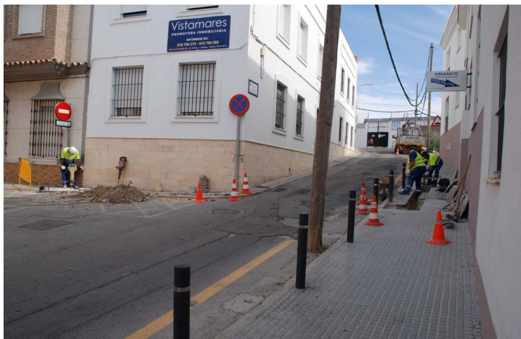
Foto 1.- Vista general de los trabajos realizados en C/. Castillo
