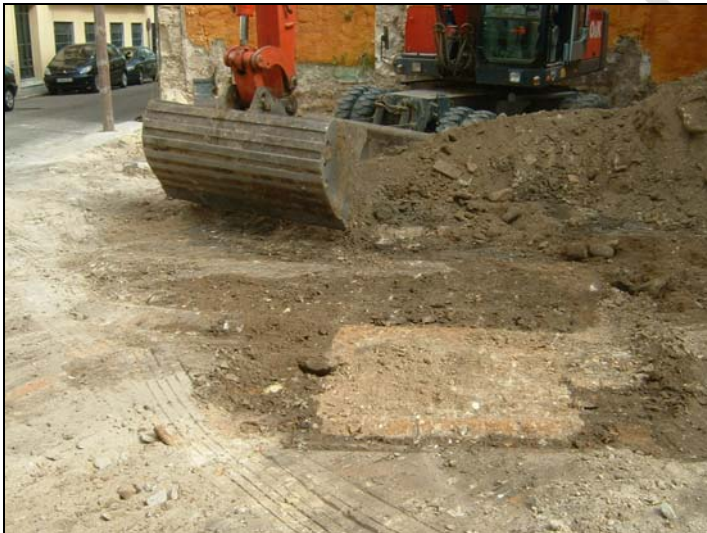
Foto 1: detalle de movimiento de tierras y cimentación de la vivienda precedente.
