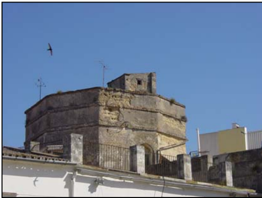
Torreón octogonal con encintado de ladrillos.
